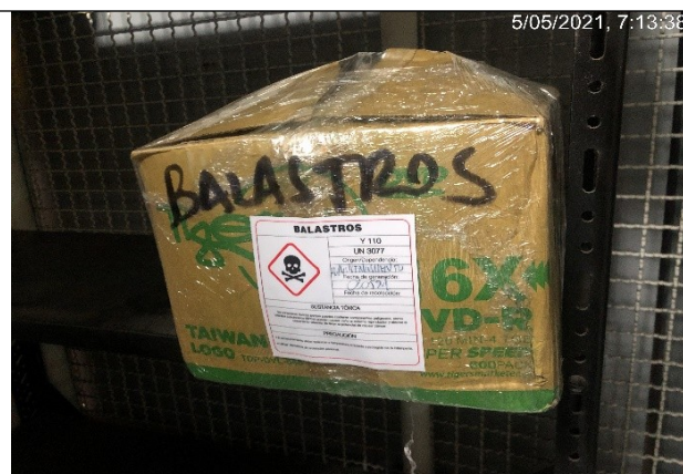
Foto 1. Etiquetado de residuos o desechos peligrosos.
